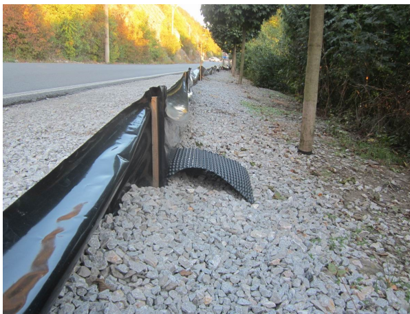
Obr. 10: Na straně směrem k řece byly položeny úkryty pro hady pohybující se podél bariéry
