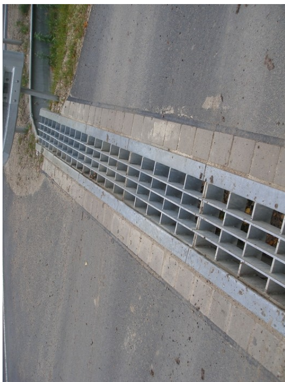
06. Podchod pod vedlejší silnicí fixovaný dlažebními kostkami
