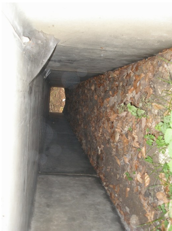
02. Podchod bez stropních otvorů
