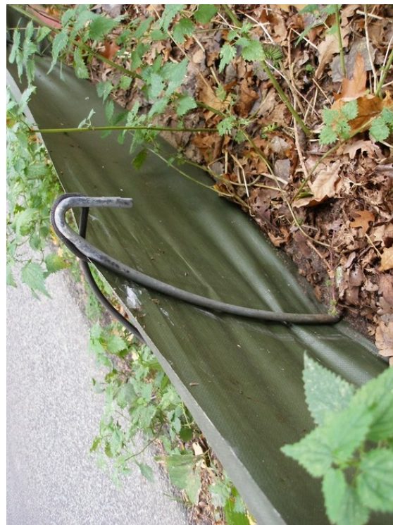
47. Upevnění plastové folie
