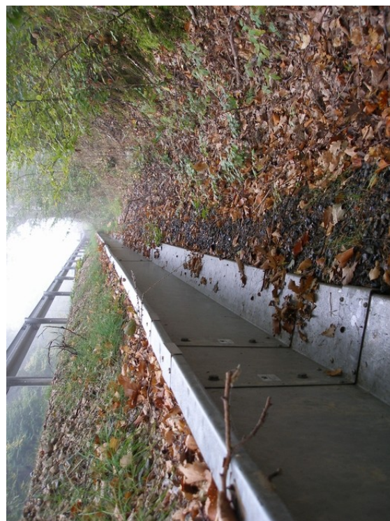
04. Detail naváděcí zábrany
