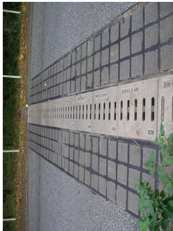
44. Upevnění podchodu dlaždicemi umožňuje snadné zásahy do podchodu
