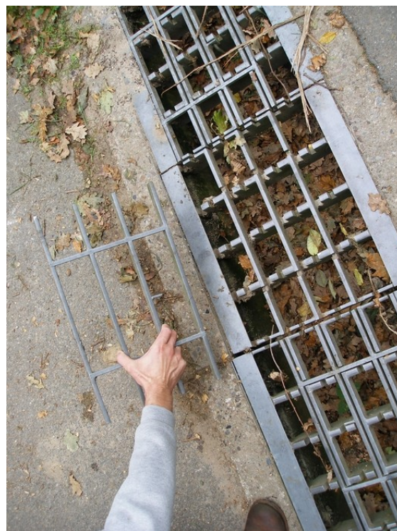
26. Rozebíratelný rošt umožňuje čištění, lze jej však snadno ukrást
