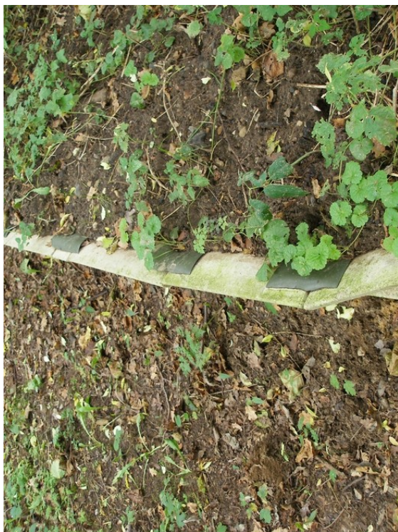
21. Překrytí spojení betonových dílů zábrany gumovými pásky
