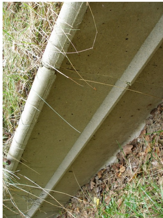
18. Napojení dílů betonové zábrany
