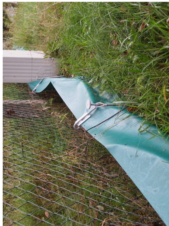
14. Řešení zábran v místě, kde není možná betonová zábrana
