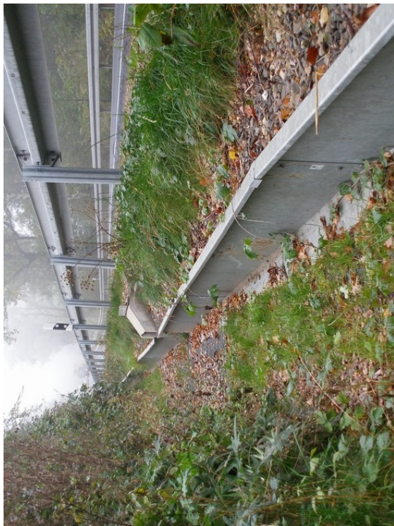
01. Naváděcí zábrana z pozink. plechu
