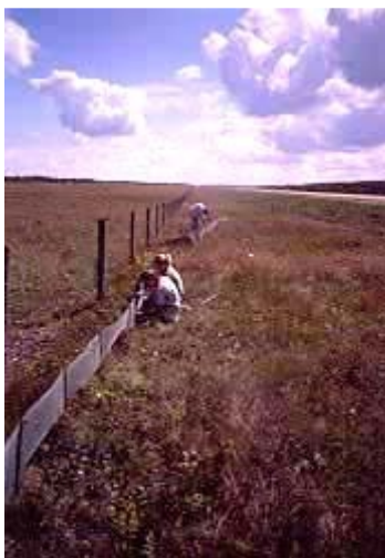
Plůtky navádějící hady do propustí
