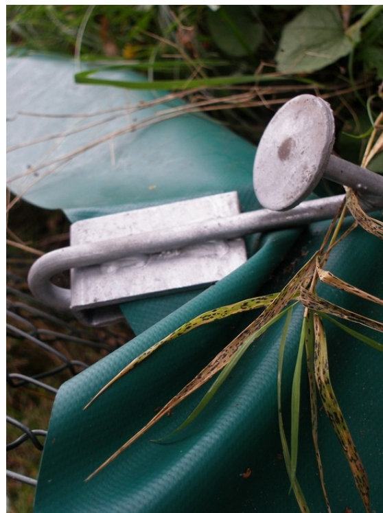
15. Upevnění folie kovovým kolíkem
