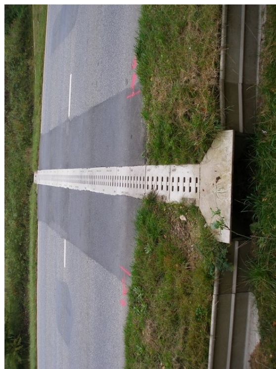
19. Fixování podchodu ve vozovce asfaltem
