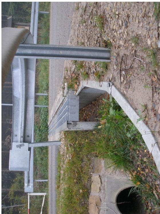
05. Podchod pod vedlejší silnicí (trubka slouží pro odvodnění silnice)
