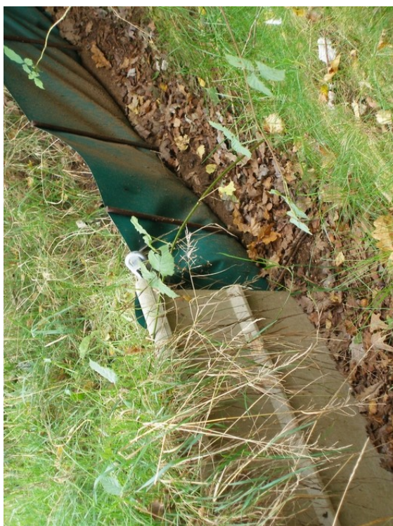
17. Napojení plastové a betonové zábrany
