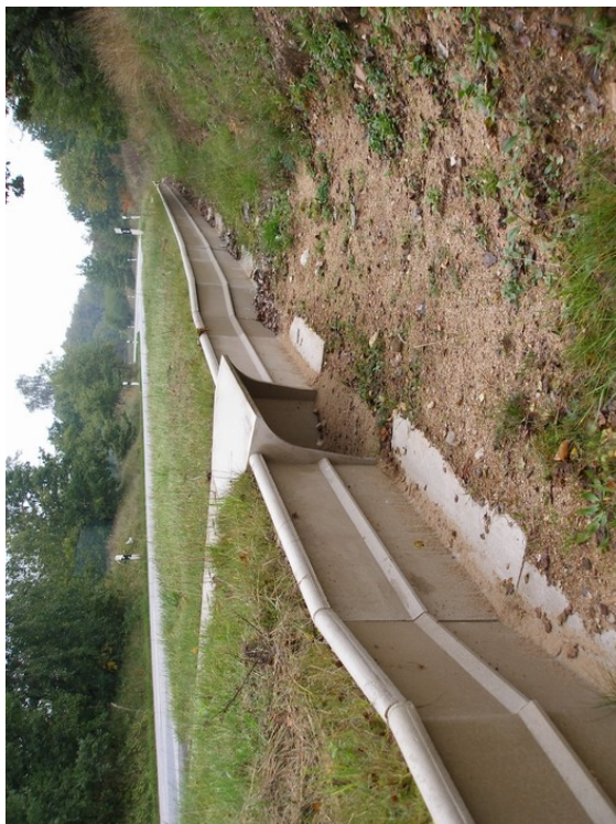
12. Zábrana a podchod z betonových dílů
