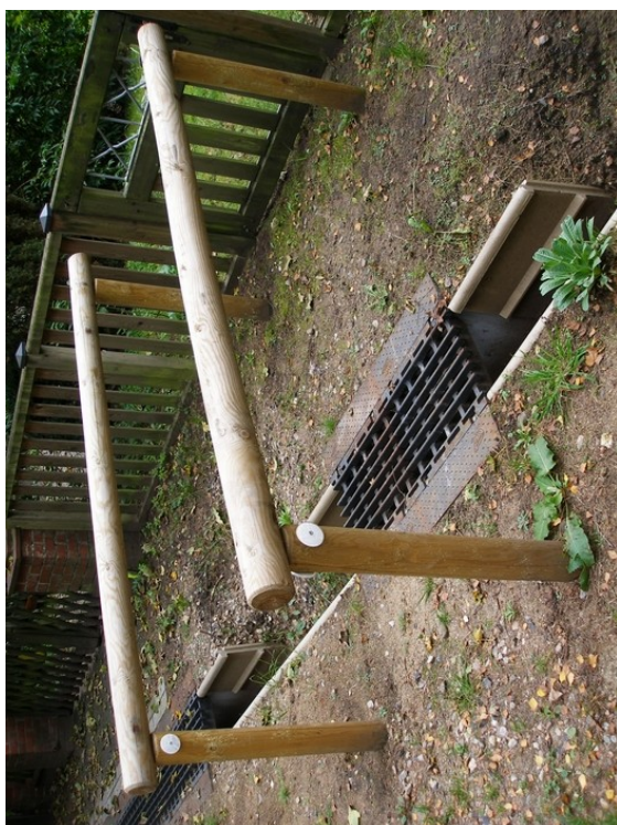
36. Roštový přejezd na zahradu a zábradlí bránící pádu do příkopu
