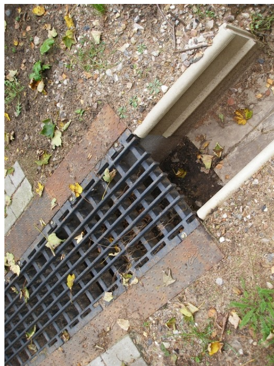
37. Napojení zábrany k roštu
