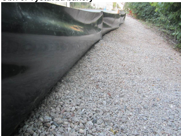
Obr. 7: Utěsnění v zemi je třeba každodenně kontrolovat a opravovat (strana bariéry k řece)
