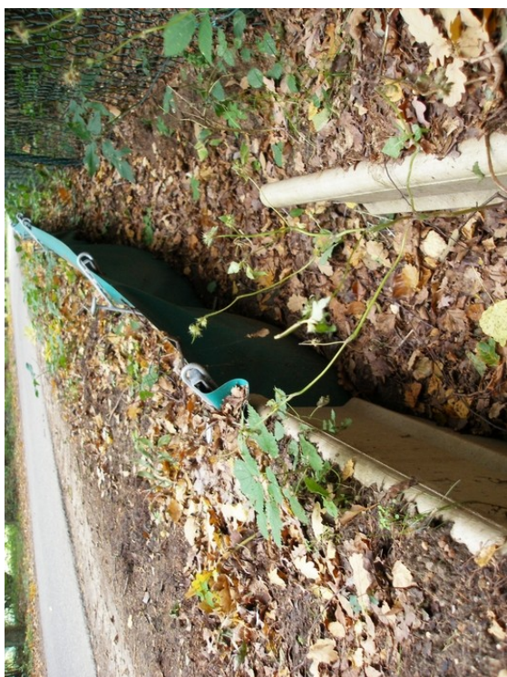
32. Napojení plastové a betonové bariéry
