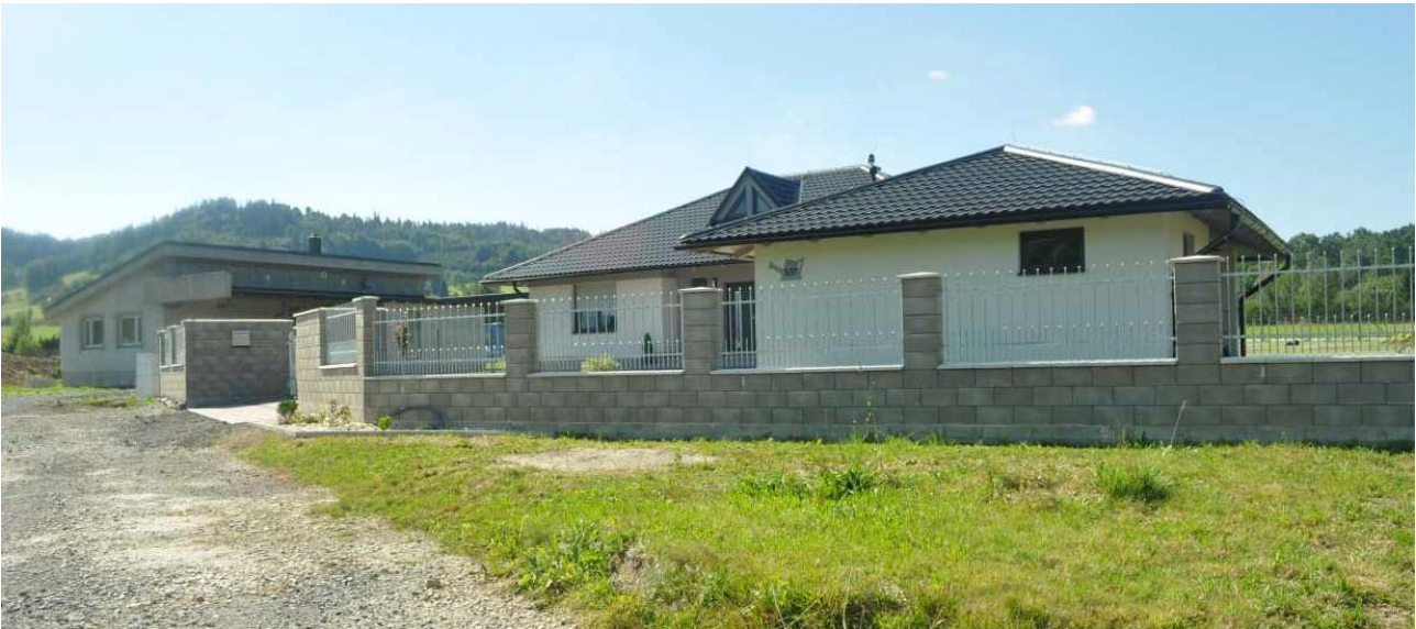
Obrázek 16: Příklad stavby nerespektující typický charakter beskydské výstavby
